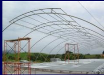
Struktur bumbung disokong oleh paip G.I. dan atap aluminium
