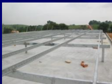
Tapak asas diperbuat daripada konkrit. Kecerunan adalah 1:10 ke arah sistem perparitan.
